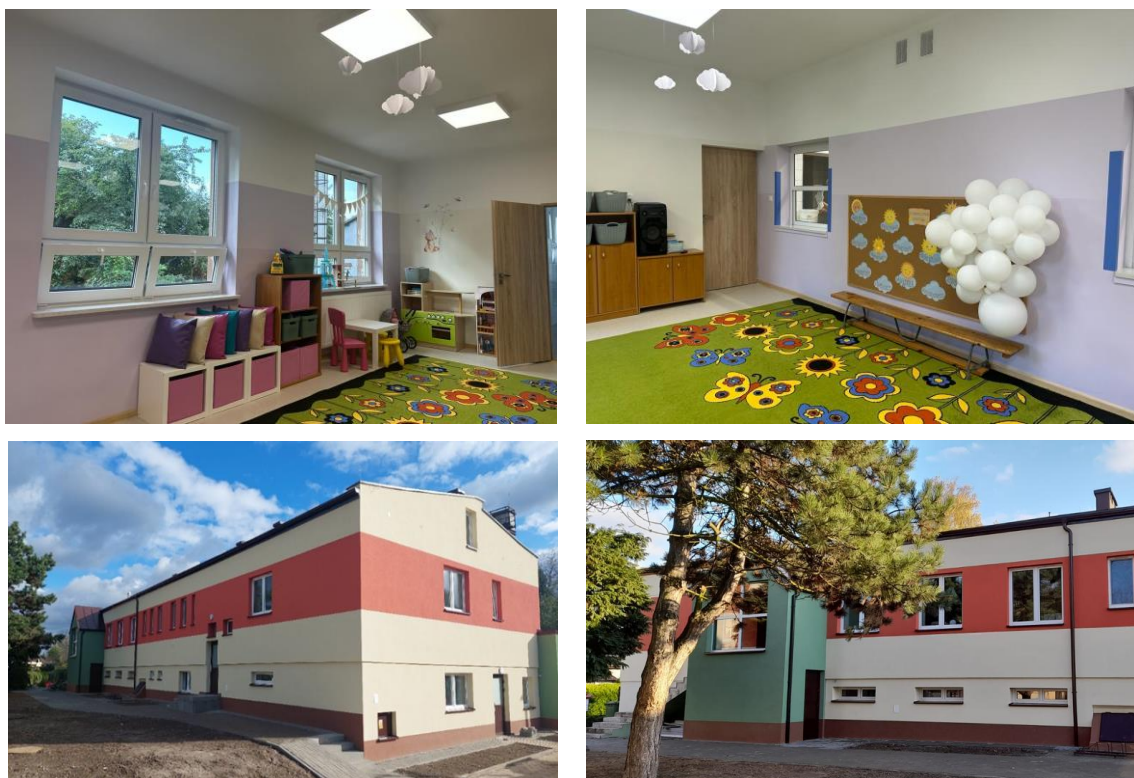
Przedszkole w Zabelkowie po termomodernizacji
