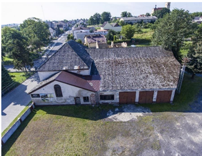
Zdjęcia obiektu przed przystąpieniem do prac
