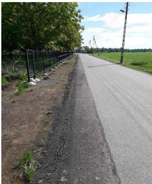
Utwardzenie poboczy na ul. Spacerowej w Zabetkowie wraz z odprowadzeniem wód opadowych - etap III - zdjęcie przed i po realizacji
