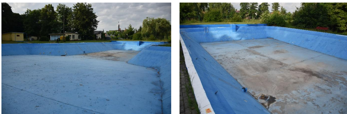
Stan techniczny basenu przed przystąpieniem do realizacji zadania
