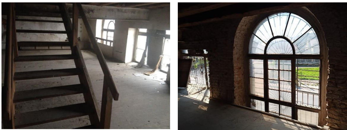
Stan budynku przed rozpoczęciem prac budowlanych
