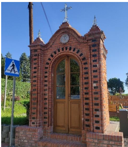
Kapliczka przy ul. Raciborskiej w Bieńkowicach po remoncie
