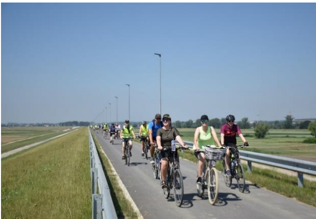
Rajd rowerowy po koronie wału zbiornika Racibórz Dolny
