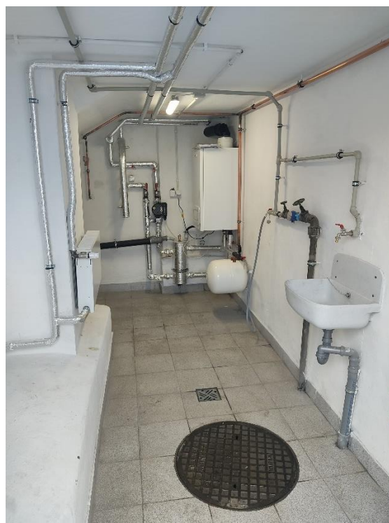
Zdjęcie kotłowni po wykonaniu modernizacji
