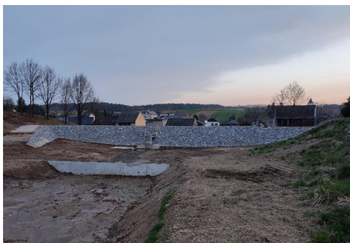
Odbudowa zbiornika przeciwpowodziowego Z 3 w miejscowości Owsiszcze
