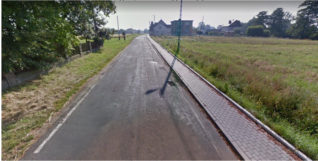
ul. Rakowiec, Główna i Wiejska w Rudyszwałdzie- zdjęcia przed realizacją inwestycji
