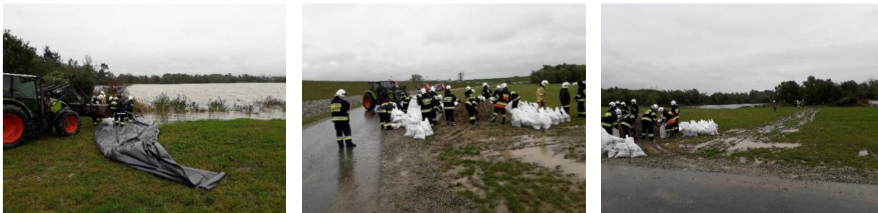
Zdjęcia powyżej przedstawiają budowę wału na tzw. Łapaczu w Krzyżanowicach
