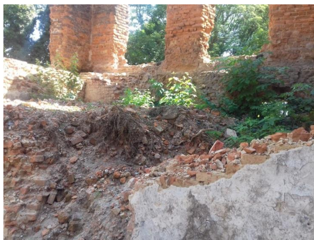
Zdjęcia prze rozpoczęciem prac
