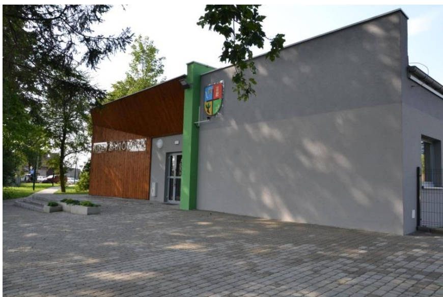
Budynek mieszkalno - usługowy w Krzyżanowicach
