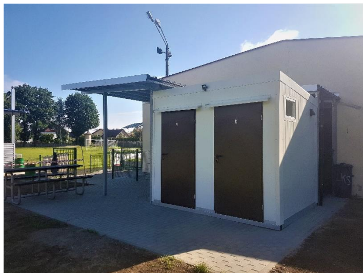
Budowa sanitariatów przy boisku LKS Tworków Fundusz solecki
