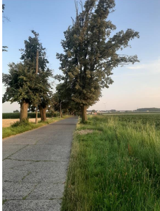
ul. Główna Nowa Wioska- zdjęcia przed realizacją inwestycji
