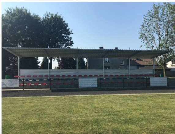
Tworków FS Budowa zadaszzenia trybun na boisku LKS
