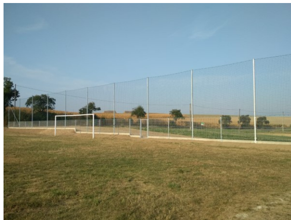
Bolesław FS Zagospodarowanie terenu przy LKS Bolesław - montaż ogrodzenia i piłkochwyty
