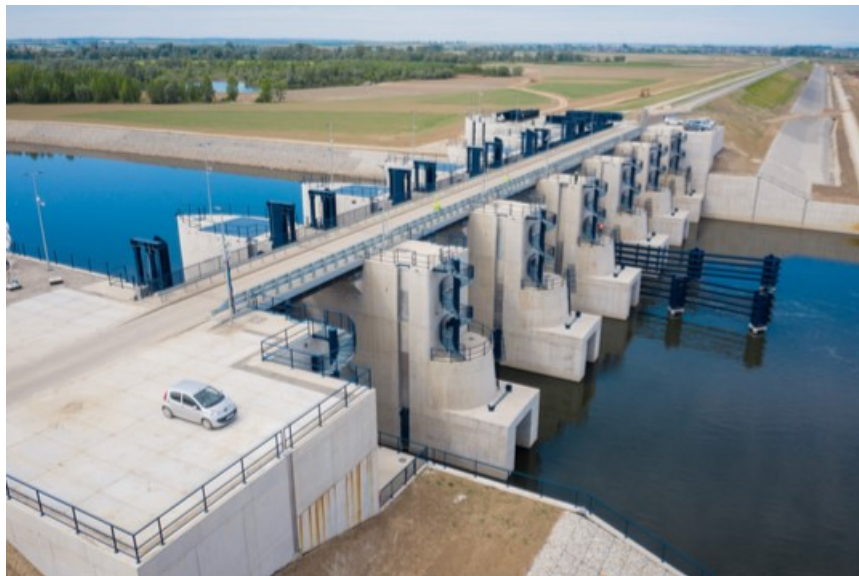
Fot. 1 Widok na urządzenie piętrzące zbiornika Racibórz Dolny (źródło: https://www.wody.gov.pl )
