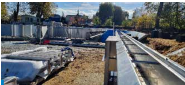
Dokumentacja fotograficzna z placu budowy – rok 2022
