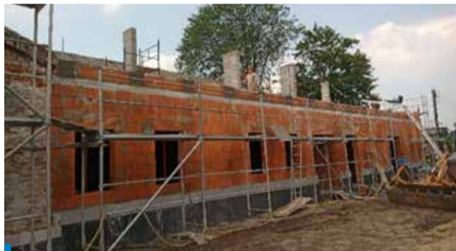
Dokumentacja fotograficzna z placu budowy - rok 2022
